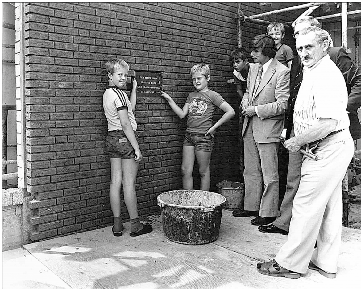
Gedenkplaat aanbrengen in het pand aan de Dorpsstraat
