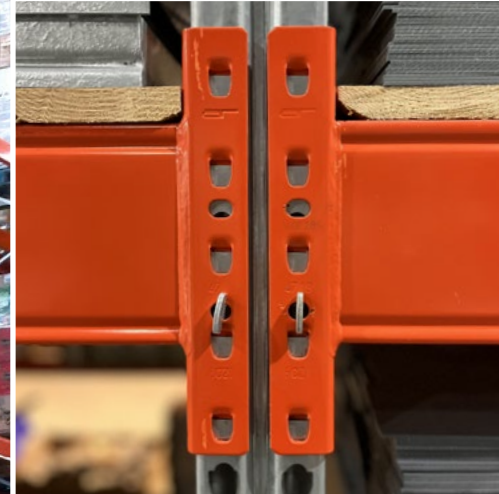
Bevestiging met een borgpen van de liggers in de staander van een palletstelling
