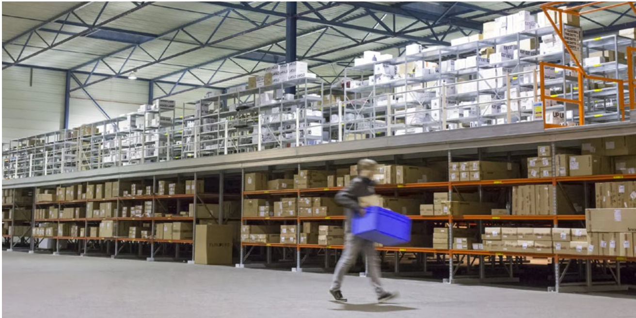
Grootvakstellingen met verdiepingsvloer bij Flinders
