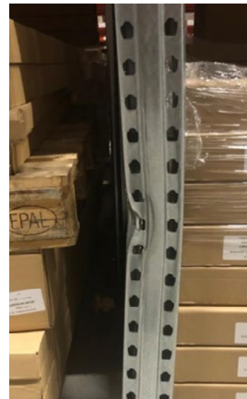
Onveilige situatie door schade aan de staander
